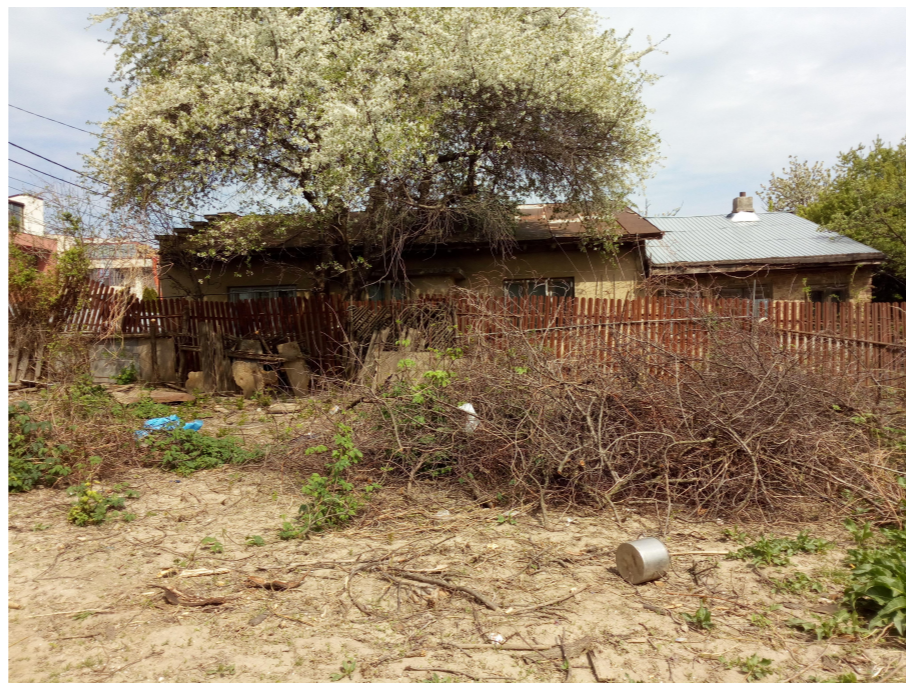
VEDERE LATURA DE NORD
